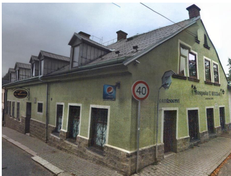
Obrázek 8 Švermova 62/19 - Ubytovna U Kozla, září 2019
